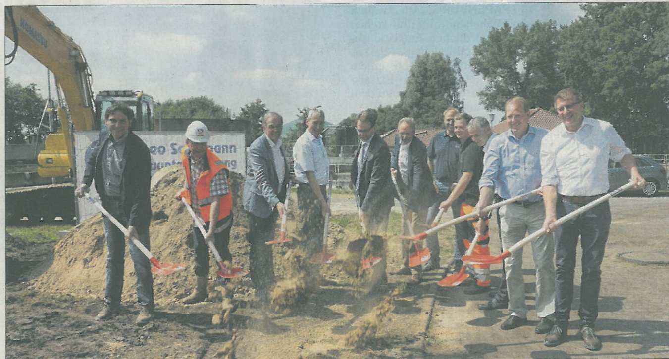
An der Kläranlage in Werlte haben die Arbeiten zur Erweiterung begonnen. Vertreter aus Politik, Verwaltung, der Planer und Baufirmen waren dabei. Foto: Mirco Moormann
